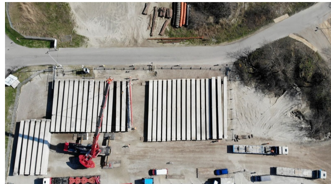
Afbeelding: Liggers plaatsen op Opslaghub IJmuiden (2024)
