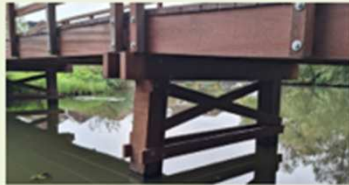
Opgelengde (hergebruik) palen als fundering
