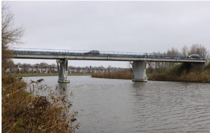
De brug over de Lage Dwarsvaart, met op de achtergrond de wijk Hollandse Hout. Foto: Fotostudio Wierd
