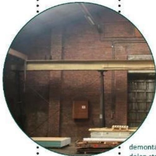
vakkundig ontmantelen betonnen brugdelen
